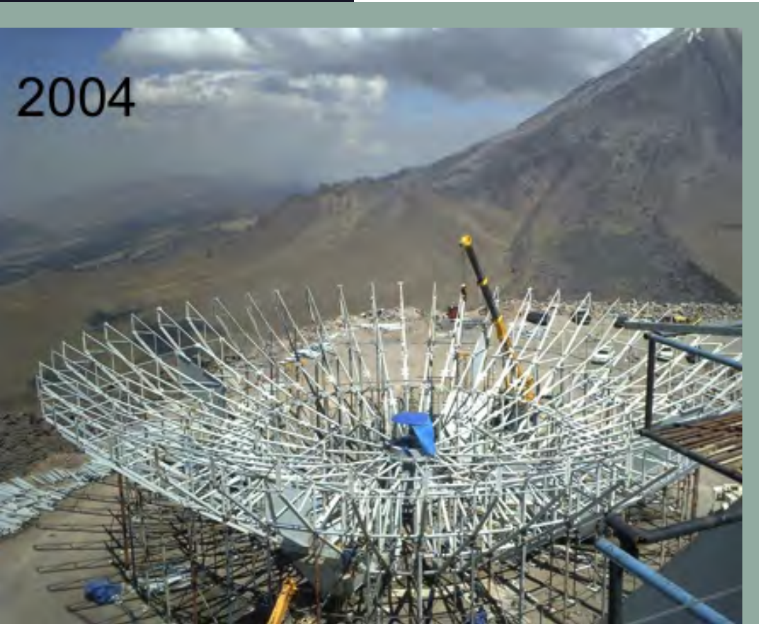
Figura 6. La estructura de la antena ensamblada en el piso.
