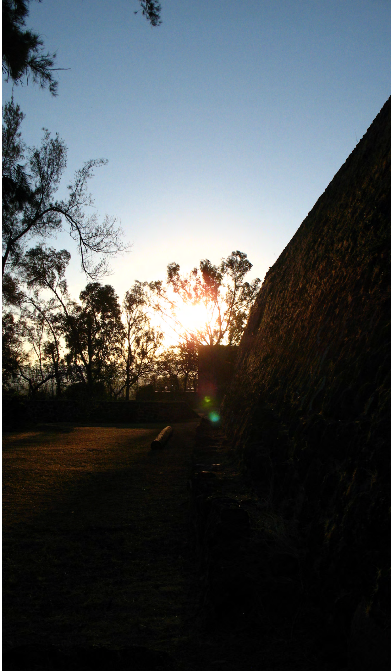
Figura 25. Ocaso sobre el talud sur el 29 de marzo de 2017. Fotografía de Francisco Granados S
