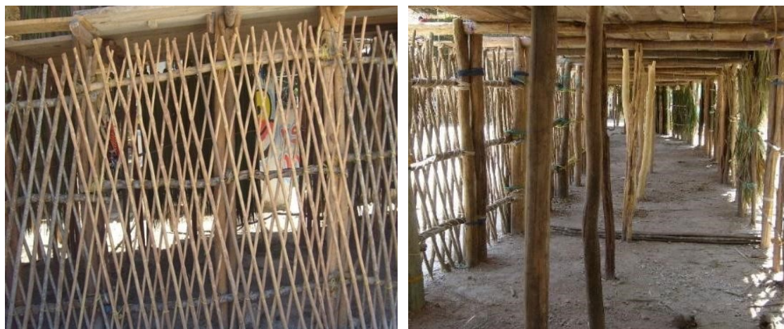
Figura 2. Estructura del koloxche’
