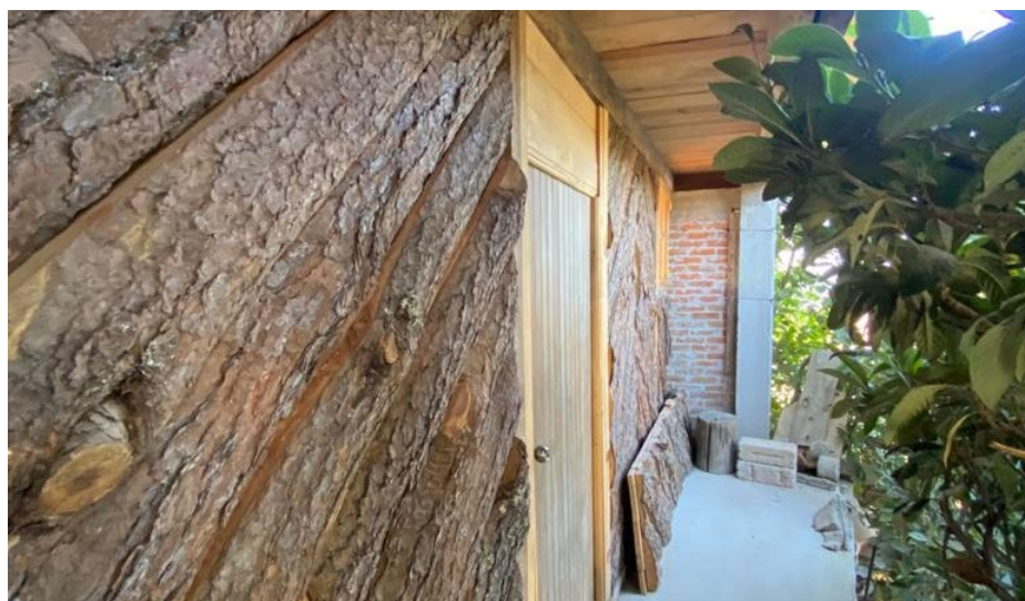
Figura 86. Construcción de cabaña a base de madera
