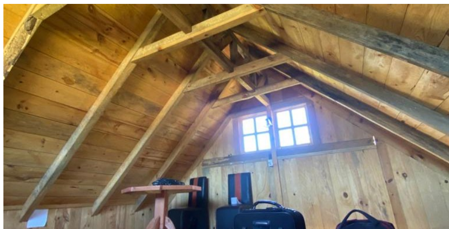
Figura 87. Construcción de cabaña a base de madera
